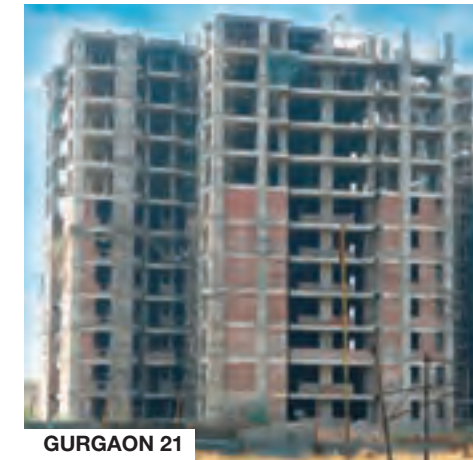
Tower E1 & E2
