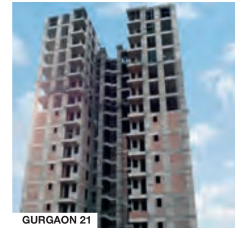
Tower F1, F2 & F3
